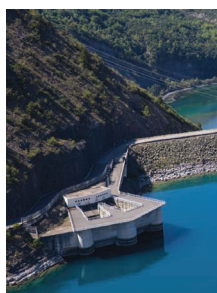
Barrage EDF de Serre-Ponçon
